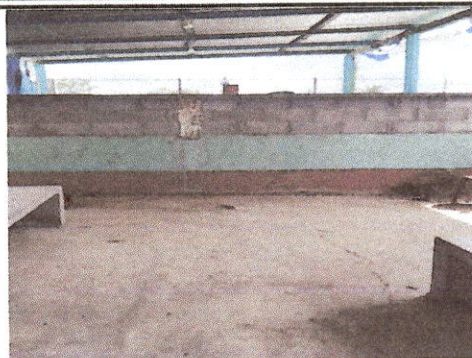
FOTO 2: Reparación de muro de block
