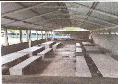
FOTO 1: Sustitución de piso de cemento liquido
