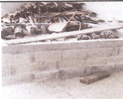
FOTO 5: Repello en muro
